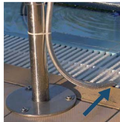
Detalle de toma de agua
