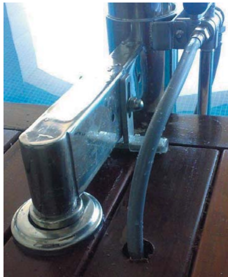
Detalle de toma de Agua
